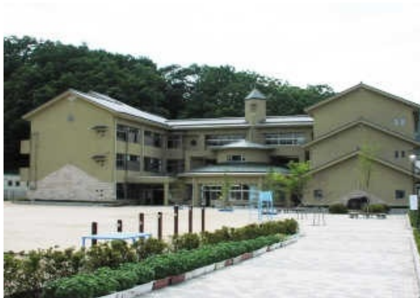
散岐小学校 平成12年2月竣工
